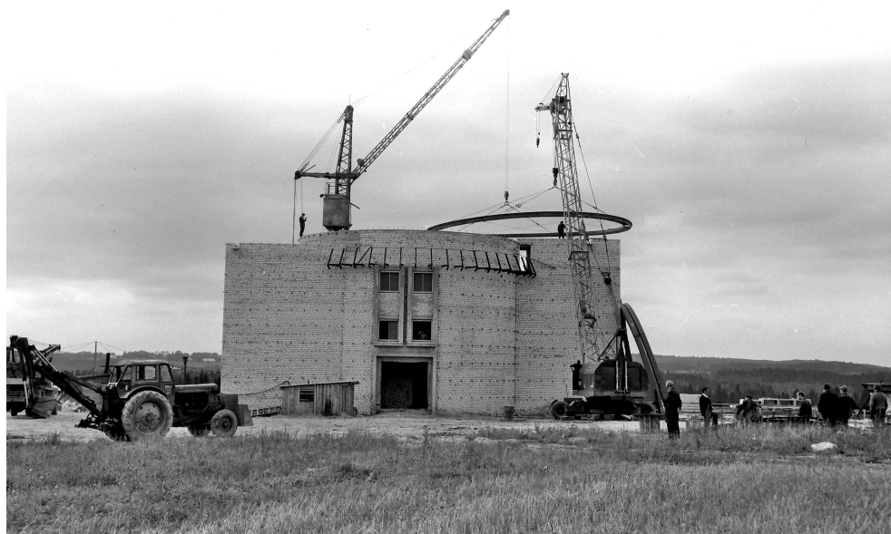
Foto 1. Kupli pööramise relsi tõstmine torni peale.
