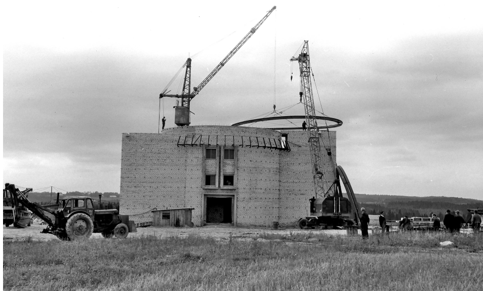
Foto 1. Kupli pööramise relsi tõstmine torni peale.
